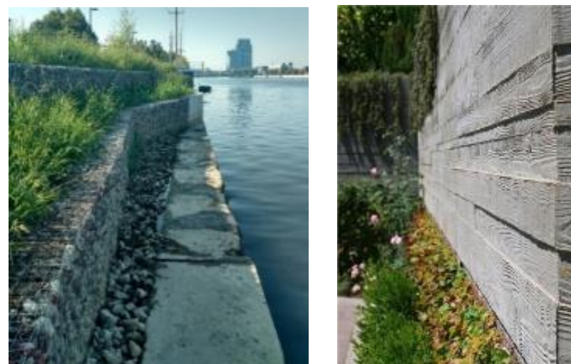
Wetland Edge & Walls
